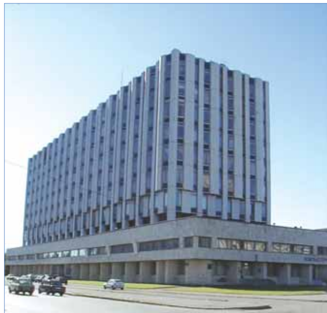
Здание ААНИИ, г. Санкт-Петербург
